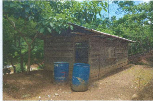
Foto 2: REPARACIÓN O SUSTITUCIÓN DE ÁREA DE COCINA
