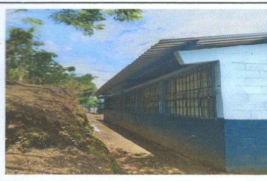
Foto 4: CANALES Y BAJADAS DE AGUA PLUVIAL
