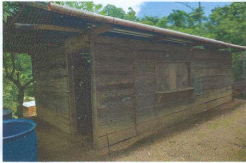
Foto1: REPARACIÓN O SUSTITUCIÓN DE ÁREA DE COCINA
