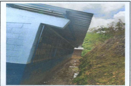
Foto 3: CANALES Y BAJADAS DE AGUA PLUVIAL
