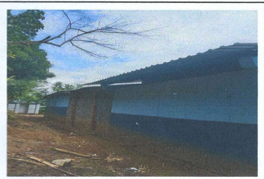
Foto 2: CANALES Y BAJADAS DE AGUA PLUVIAL
